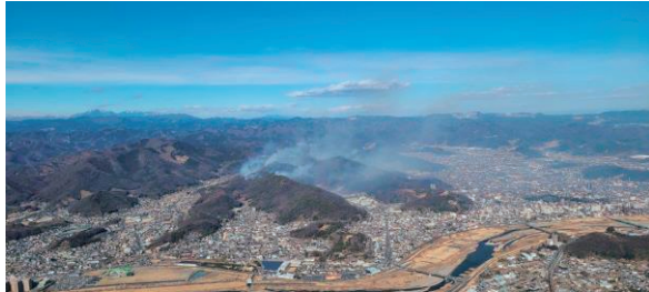
両崖山及び天狗山全景 (横浜市消防局提供)
